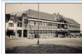
La construction de la colonie en 1938 (archives nationales, Papers Jean Zay)
